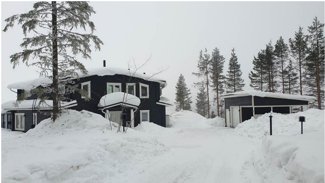
Kuva 7 Korttelin 13 uusi lomarakennus
